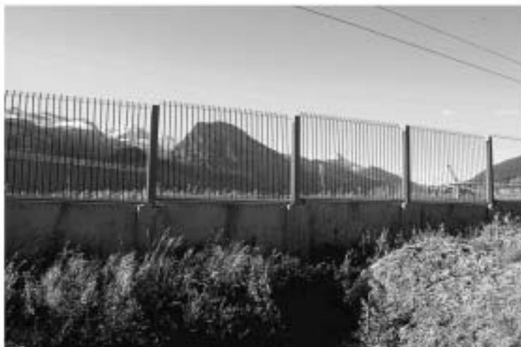
*Esempio di pannelli antirumore in Svizzera contrassegnati con delle strisce per impedire gli impatti da parte degli uccelli (fotografia di Hans Schmid).*
