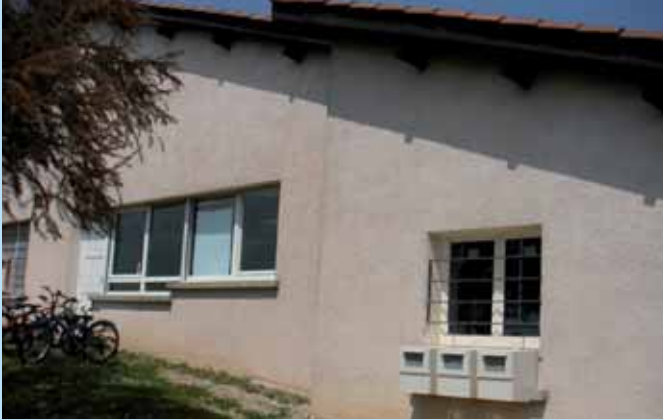
Fenêtre active vue de l'extérieur (site de Jons)
